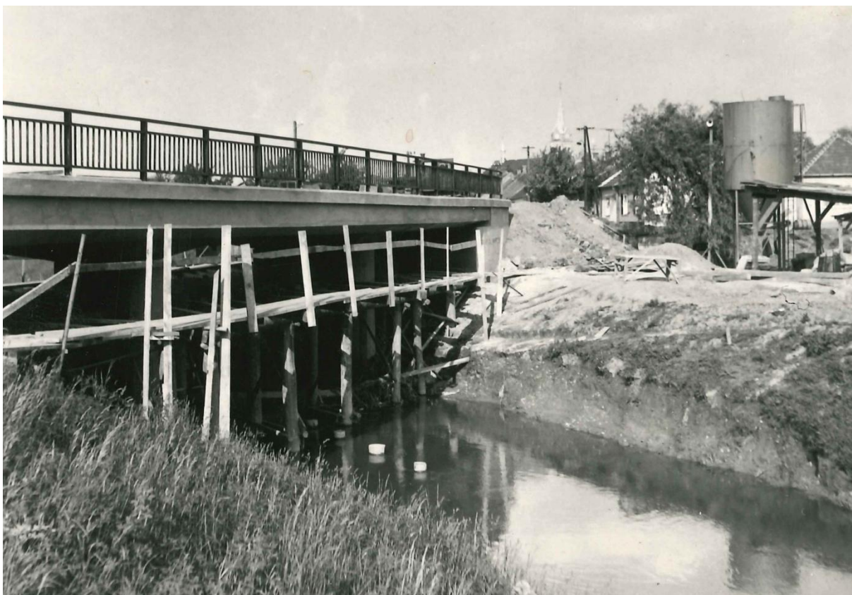
Stavba nového mostu
